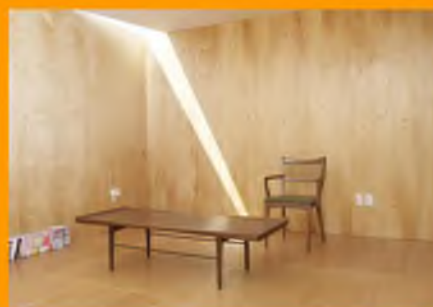
Применение фанеры пониженной токсичности марки ФК для внутренней отделки помещений.
