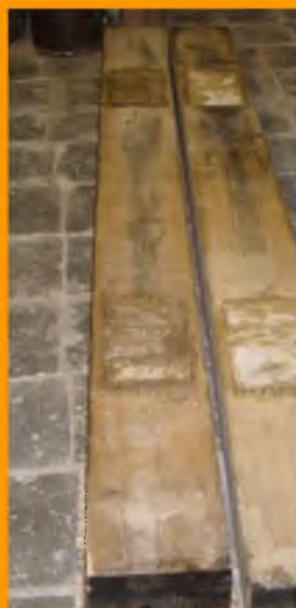
Шпалы широкой колеи с подрельсовыми прокладками из прессованной древесины плотностью 1200 кг/м 3
