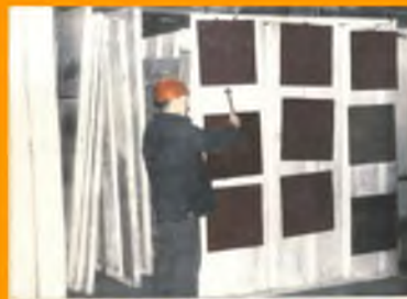
Правка панелей внутренней облицовки вагонов-рефрижераторов с применением СВП (фрагмент капитального ремонта вагона)
