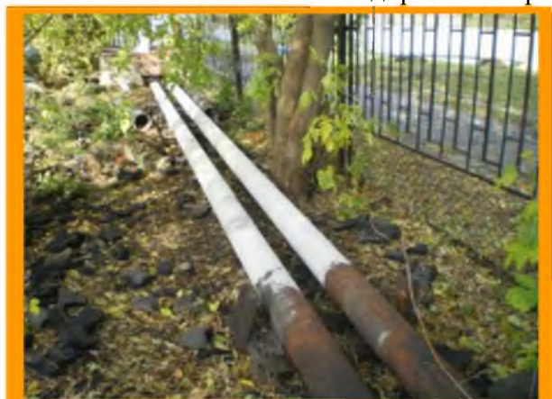
Теплоизоляция теплотрассы с нанесением КТВП
